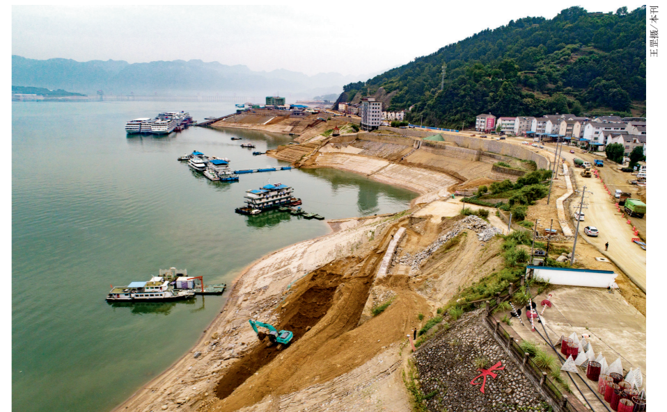
5月29日，湖北省秭归县茅坪镇银杏沱水域库岸生态修复工程现场
