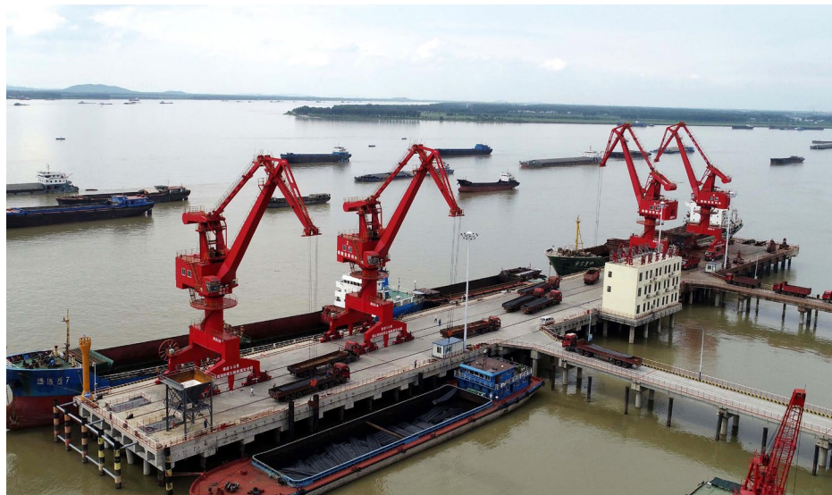
► 近日，安徽铜陵首座“以电代油”岸电码头——长江东苑码头正式投入运营。岸电工程是一种“以电代油”电能替代工程，是目前港航领域节能减排最具前景的技术。东苑码头先后投入了1.3亿元进行升级改造，将原本使用柴油的栈桥、场桥、停靠船舶等全部技术改造为用电，达到“零排放”，减少空气污染，改造后的东苑码头成为长江安徽段首个“零排放”的绿色码头。CNSphoto 供图
